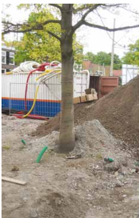
Bouwwerkzaamheden na aanplant.
