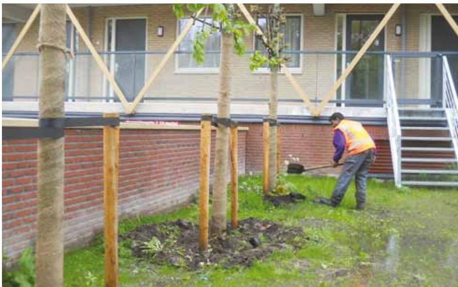
Problemen met teveel water door versmeerde bodem.
