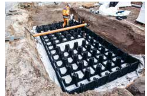
Met de losse elementen is het systeem flexibel en aan te passen aan de situatie ter plaatse. Zo kunnen (onverwachte) bestaande leidingen zonder problemen door de groeiplaats lopen, zonder ingrijpende werkzaamheden.
