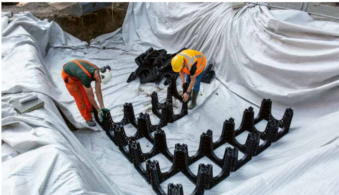
Geotextiel moet de voedingsrijke grond die in de groeiplaats wordt gestort scheiden van het zand buiten de groeiplaats. De eerste laag RootSpace wordt aangebracht. Het systeem is eenvoudig in elkaar te klikken. Na het vullen en plaatsen van de deksels wordt de groeiplaats helemaal ingepakt met het geotextiel.
