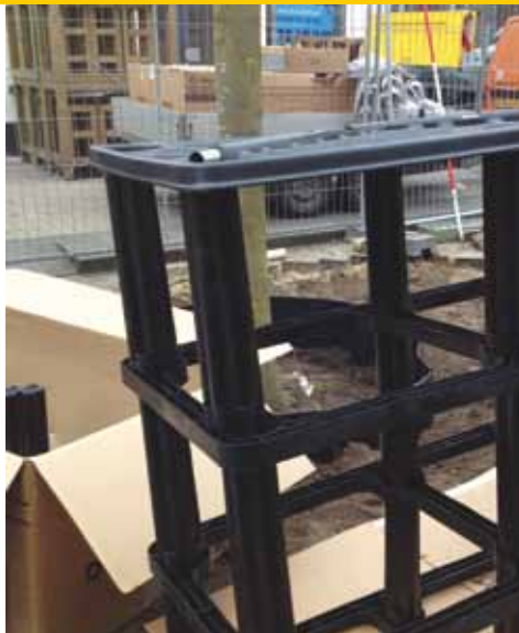
De Silva Cell constructie, een laag is 40 cm hoog.
