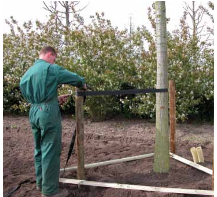
07 Leg de verankeringslaten op de grond, zodat precies gemeten kan worden waar de gaten in de grond geboord moeten worden.
