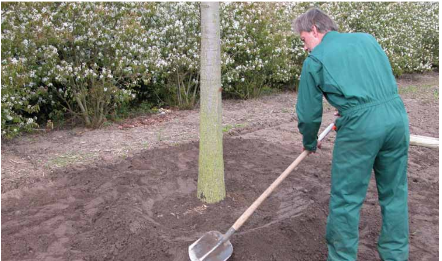
03 Breng een opstaande rand op het maaiveld aan. De rand moet iets groter zijn dan de diameter van de kluit.
